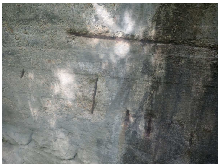
Foto č. 5 Opěra O 02 – zleva – průsak vody, koroze armatury
