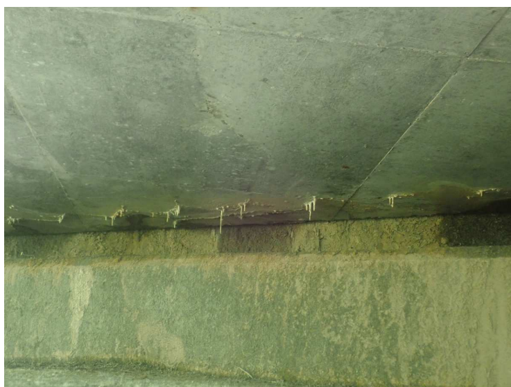
Foto č. 1 Konstrukce K 01 – nad O 01 – průsak vody a pojiva
