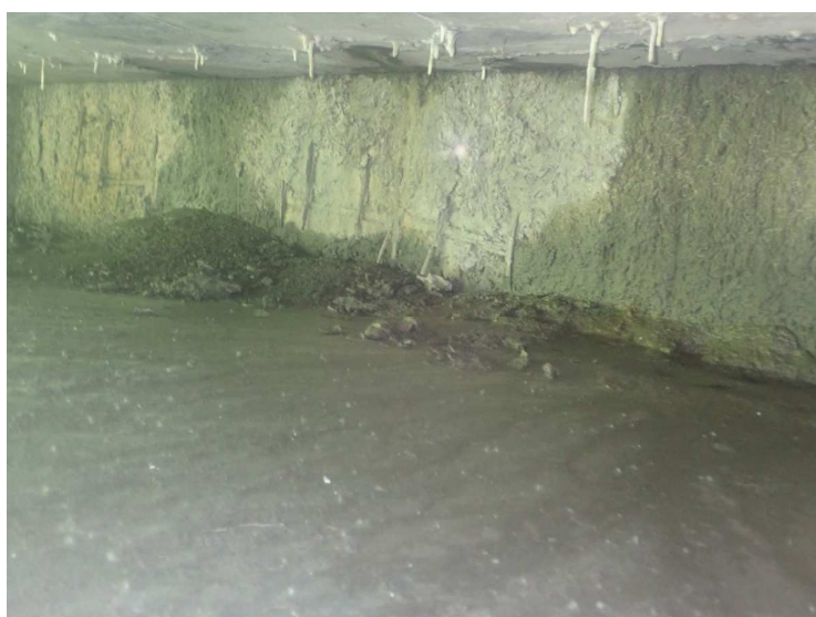
Foto č. 3 Konstrukce K 01 – nad O 01 – průsak vody a bláta příčnou spárou
