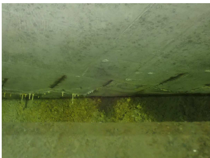
Foto č. 2 Konstrukce K 01 – nad O 02 – průsak vody a pojiva
