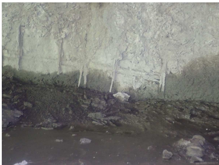
Foto č. 4 Opěra O 01 – závěrná zeď – průsak vody, koroze armatury
